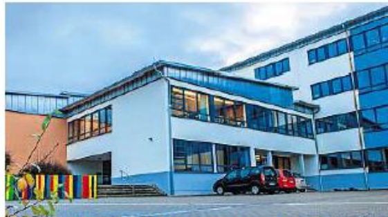
So sieht die Küpser Schule aktuell aus. Das Hauptgebäude wurde bereits saniert. Beim älteren Mittelbau kommt jedoch der Neubau günstiger. Foto: Philip Herr
